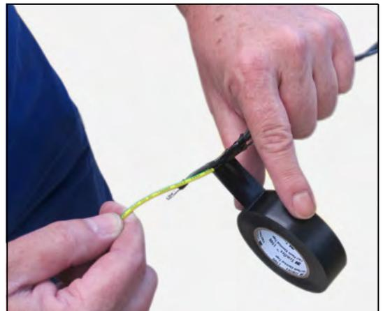
14. An den gelösten Kabeln den Zugdraht in den Prüfraum ziehen.
