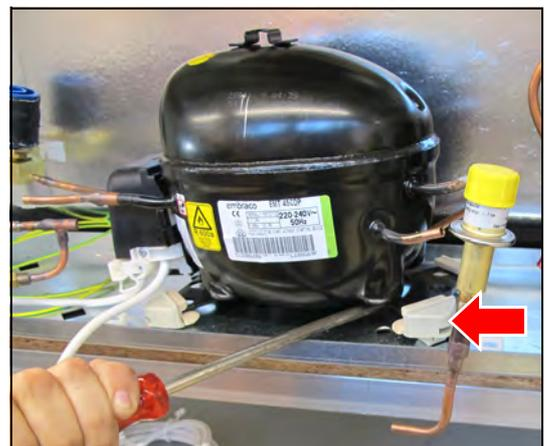
16. Von unten die Klemmnasen der Halterung mit einer Rohrzanze eindrücken.
