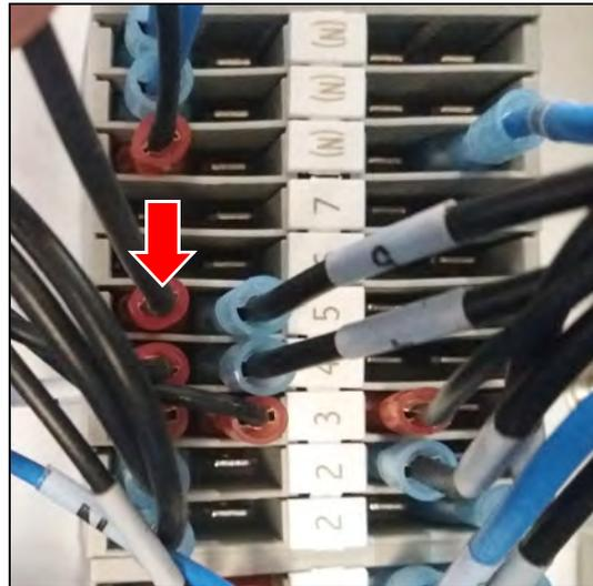
6. Am I/O-Board das Kabel (Heizen SSR N) der alten Rippenrohrheizung lösen.
