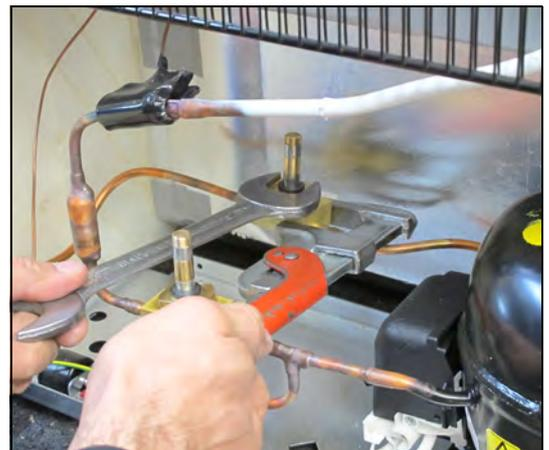
45. Auf beide Magnetventile Dauermagnete aufsetzen um die Magnetventile zu öffnen.
