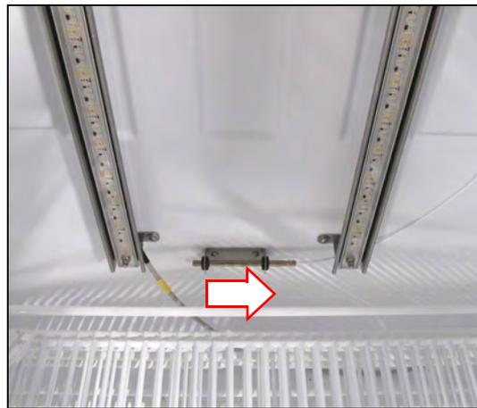
4. Stecker des Temperatursensors am I/O-Board im Komponentenraum mit geeigneter Zange abziehen.
