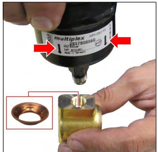
33. Trockner. und Schauglas wieder in den Kältekreislauf schrauben.
