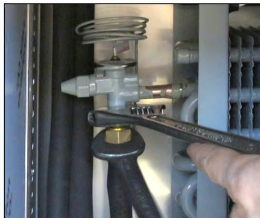
9. Düse aus dem Einspritzventil und Kupferdichtung entfernen.
