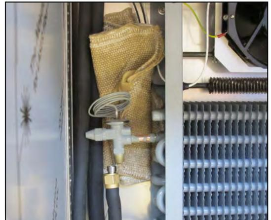
11. Stickstoffflasche öffnen und Kältekreislauf mit Stickstoff fluten.
