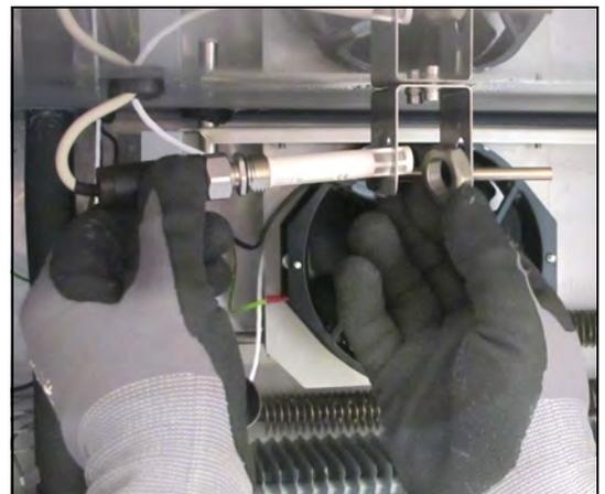
3. Halteschraube des Feuchtesensors lösen und Feuchtesensor abziehen.
